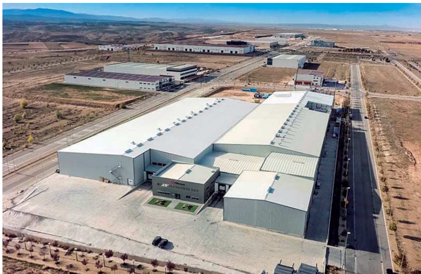
Las obras tienen un plazo de ejecución de cinco meses.
